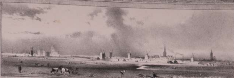
VOIE EXTÉRIEURE DE SAND. PRISE DE CRÈME DE TINGHIENNES
